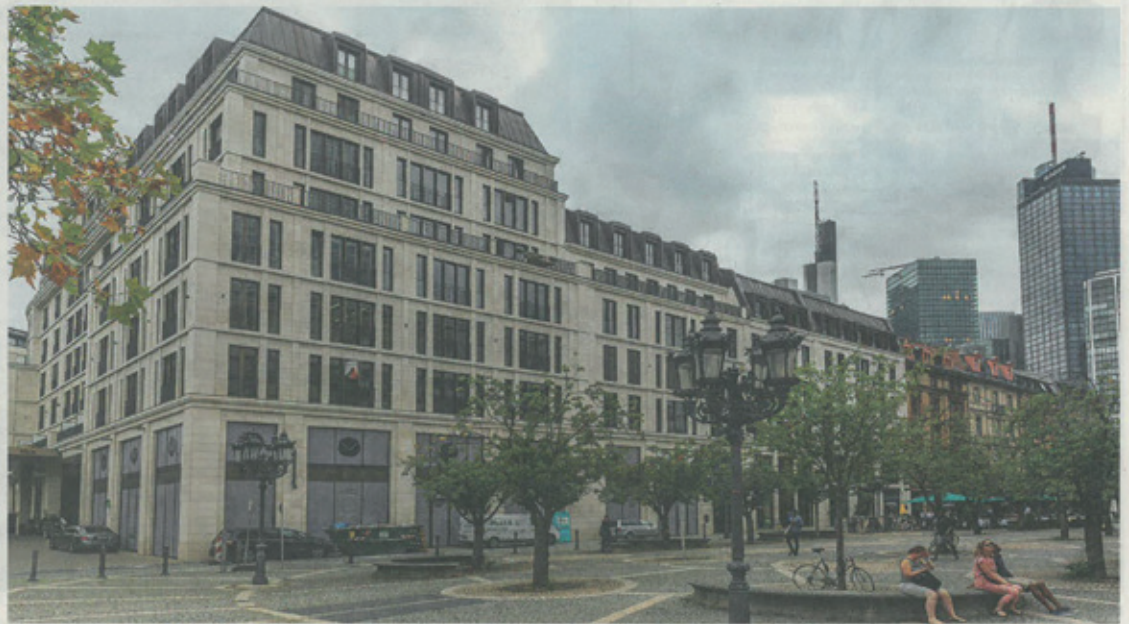
Feine Adresse: Satellite Office zieht in den Hotelkomplex am Opernplatz ein.
